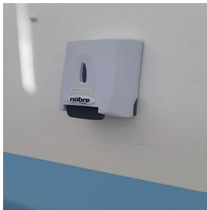
Figura 19 Instalação de dois dispenser de álcool no corredor dos pacientes.
