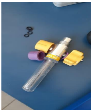
Figura 114 Troca retentores do fluxometro e instalação no setor.
