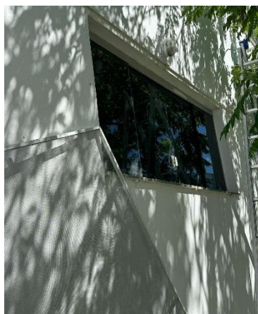
Figura 87Reposição de mosquiteiro do setor.
