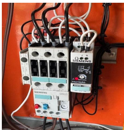
Figura 110 Corretiva no relê da bomba de incêndio.
