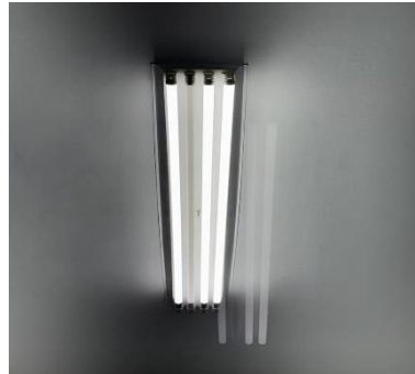
Figura 152 troca de lâmpada queimada no setor.
