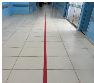
Figura 140 Instalação da faixa de guia vermelha nos corredores.
