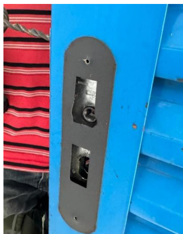
Figura 127 Instalação de fechadura no setor.
