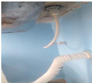
torneira Figura 15Corretiva na mangueira de água da.
