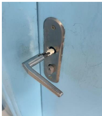
Figura 83 troca da fechadura no setor.
