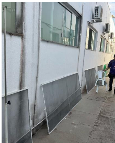
Figura 89 Reposição das telas de proteção do setor.
