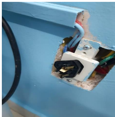
Figura 18 Troca de pino da tomada de força da impressora.
