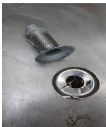
Figura 117 troca da válvula do tanque do setor.
