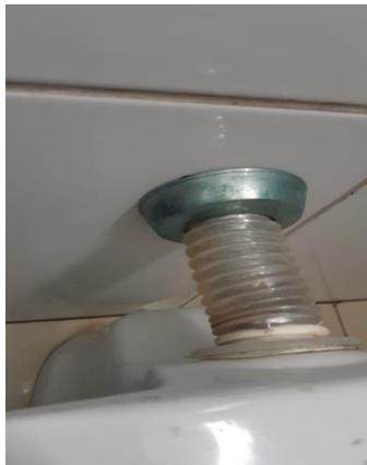
Figura 112 troca do sifão do vaso sanitário.
