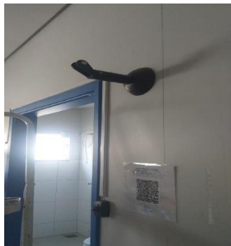
Figura 169 Retirada do ventilador do setor para corretiva.
