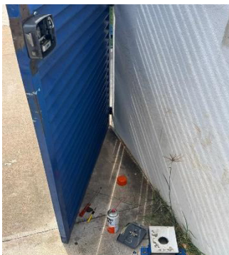
Figura 39 Corretiva e lubrificação no portão de entrada.
