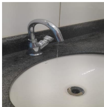
Figura 171 Troca da torneira com vazamento no setor.
