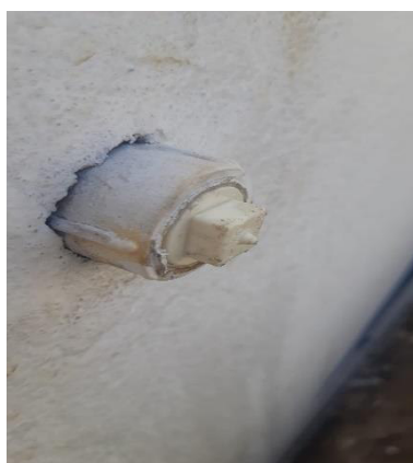
Figura 160 Instalação de torneira externa no setor.
