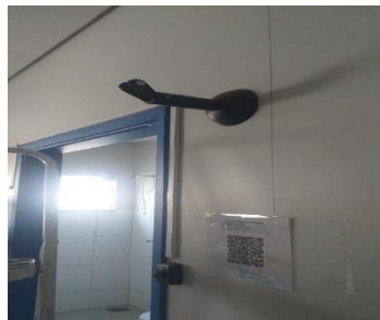
Figura 23 Retirada do ventilador do setor para corretiva.
