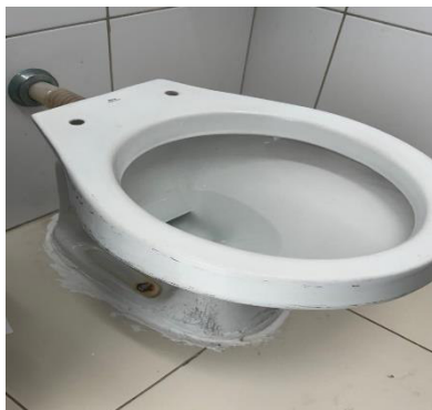
Figura 138 Corretiva de fixação de vaso no setor.
