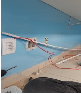
Figura 29 Montagem de tomadas no setor.
