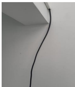
Figura 67 Instalação de canaleta na fiação da Tv.
