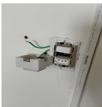
Figura 42 Instalação de tomada externa no setor.
