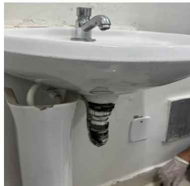
Figura 100 Troca da válvula da pia e sifão do setor.
