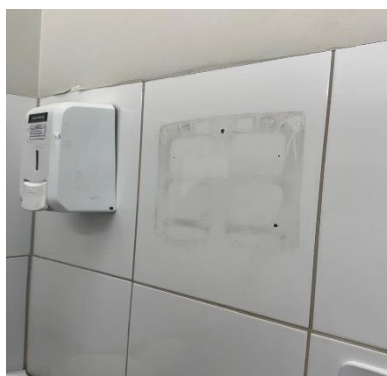
Figura 5 Instalação de dispenser de papel
