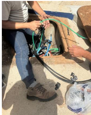
Figura 47 Paasagem de cabeamento da nova central de O2.
