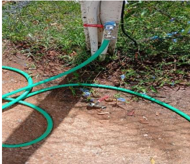
Figura 99 Instalação de torneira na área externa.
