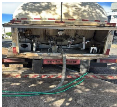
Figura 155Recebimento de recarga do tanque de O.2.
