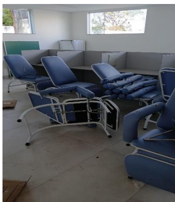
Figura 96Montagem do braço das poltronas dos setores.
