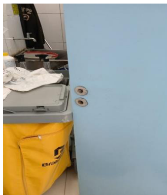
Figura 166 Corretiva na fechadura do setor.
