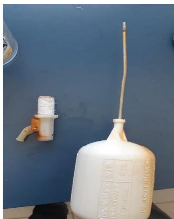
Figura 119Troca da boia do reservatório da caixa d'água do setor.
