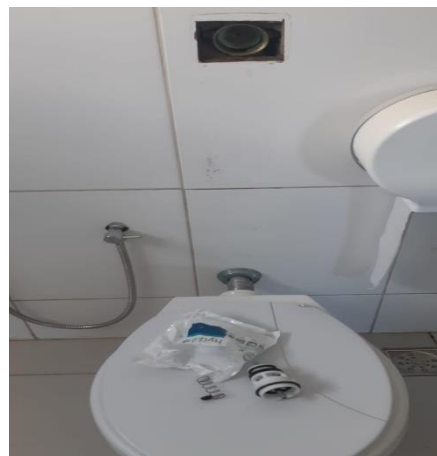
Figura 164 Instalação de válvula hydra no setor.
