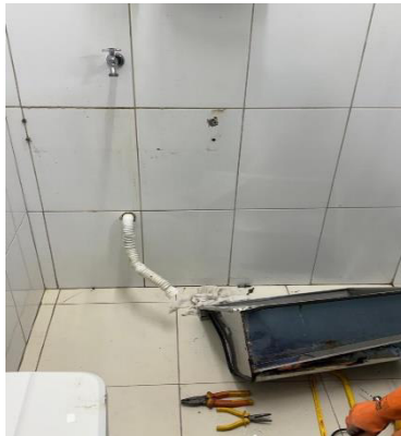
Figura 149 Corretiva no tanque do setor.
