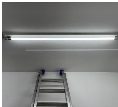
Figura 107 troca de lâmpada queimada no setor.
