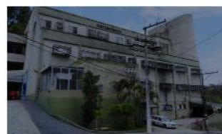
Cidade: Caieiras - SP Hospital Maternidade de Caieiras
