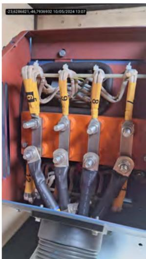
**Verificar as conexões do regulador de tensão e informar a resistência (ôhmica) do estator da excitatriz (F+ F-)**
